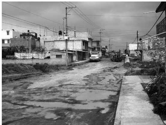
FOTO 5: EMPIEZA EL PROYECTO DE PAVIMENTAR LAS CALLES EN COLONIA ROMA
