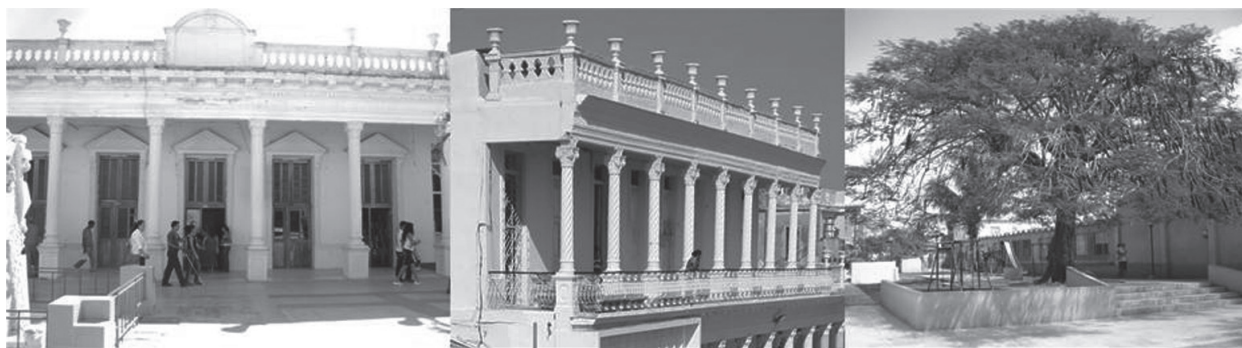
FIGURA 5. LA CALLE INDEPENDENCIA EN EL CENTRO DE LA CIUDAD DE CIEGO DE ÁVILA, DESPUÉS DE LA INTERVENCIÓN INTEGRAL.
