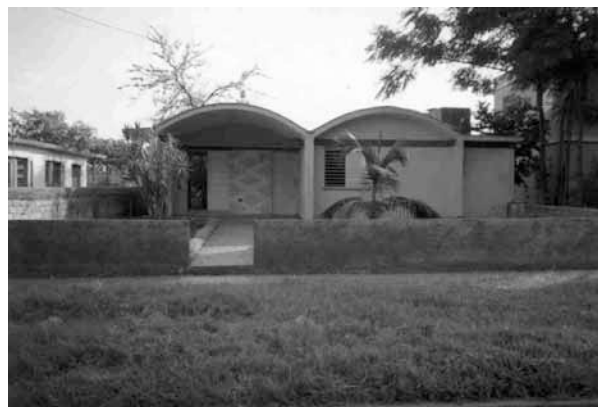
FOTO 15: Primera vivienda construida con bloques machihembrados de suelo cemento en la ciudad de Matanzas (proyectada por la autora en 1992). Esta fue la solución constructiva más empleada en las viviendas de "bajo consumo" a lo largo del país durante la década de los años '90s. Foto tomada por la autora, 1993.
