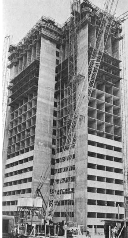
FOTO 9: Edificio de 12 plantas en construcción con el Sistema IMS. Fuente: REBELLÓN, Josefina. Arquitectura y desarrollo nacional. Cuba 1978. 1ª. ed. La Habana, Editorial CEDITEC. 1978.
