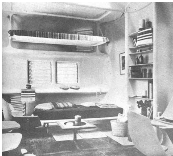
FOTO 3: Vivienda experimental en materiales laminares. Mercedes Álvarez y Hugo D'acosta, 1965 – 1968. Imagen interior del prototipo realizado en asbesto cemento. Fuente: SEGRE, Roberto. 10 años de Arquitectura en Cuba Revolucionaria. 1ª. ed. La Habana, Ediciones Revolucionarias. 1970.
