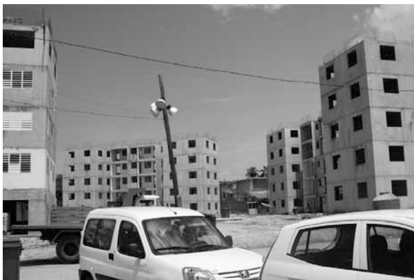
FOTO 17: Nuevas urbanizaciones que se ejecutan en la ciudad de La Habana con tecnología de sistema de moldes metálicos recuperables. Foto tomada por la autora en agosto 2008.
