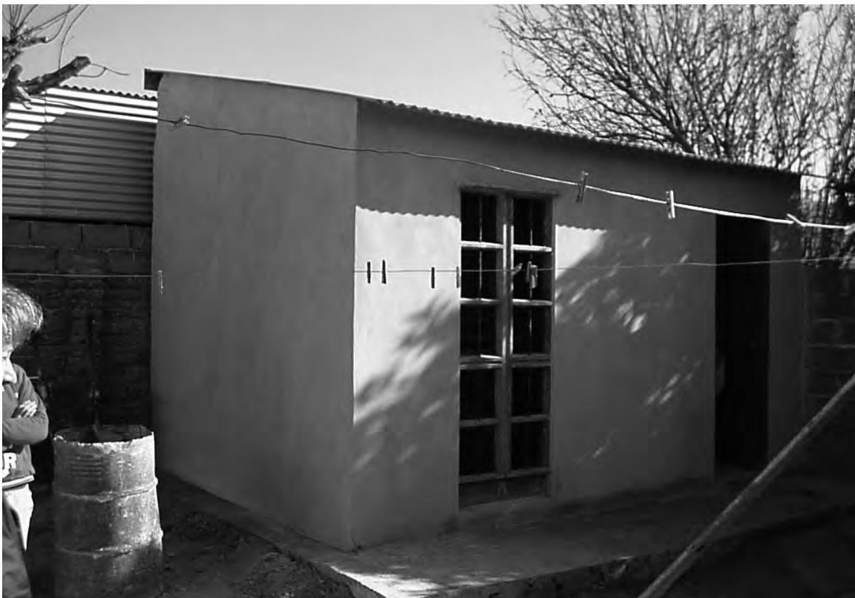
dos de construcción, patentada por el CEVE con el nombre de sistema constructivo UMA, llenada con hormigón del tipo convencional, con agregados pétreos). Las fundaciones consisten en plateas de hormigón armado, con un alisado superficial que es su acabado final, sin aplicación de pisos. La misma solución se adoptó en veredas perimetrales.
