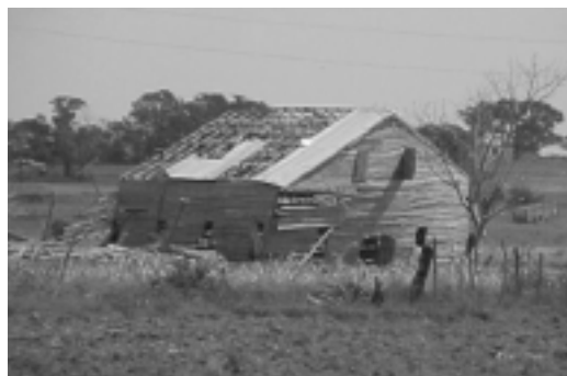
IMAGEN 4. UNA DE LAS 11 120 CASAS DE CURADO DE TABACO, DERRIBADAS O SEVERAMENTE DAÑADAS POR EL HURACÁN LILI, EL CUAL AZOTÓ LA PROVINCIA DE PINAR DEL RÍO, LA MÁS OCCIDENTAL DE CUBA, EL 1 DE OCTUBRE DEL 2002.
