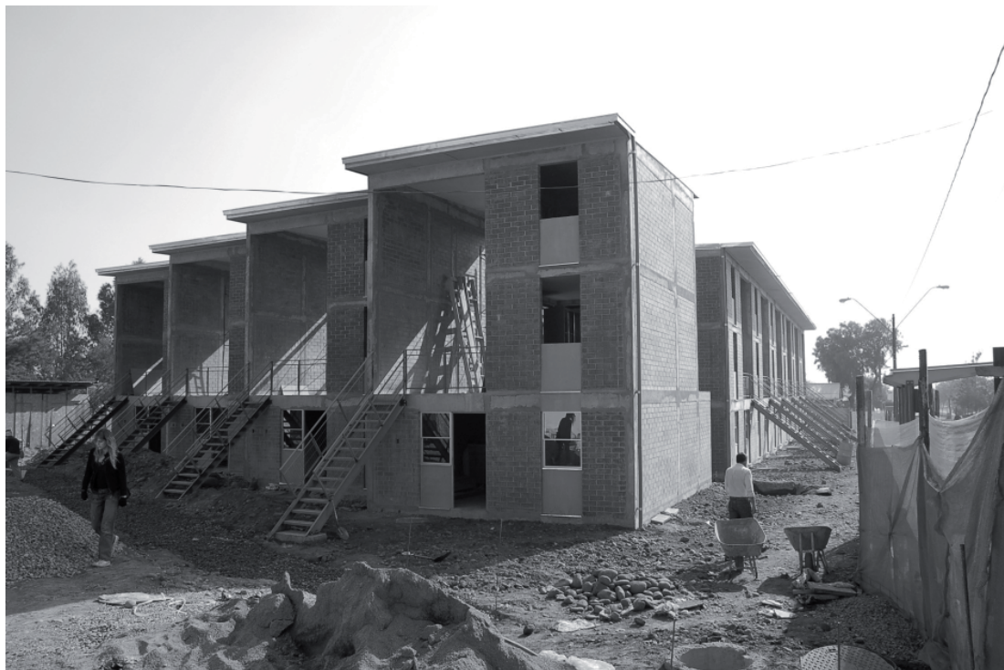
Foto 7. Proyecto Juntas Podemos, 30 viviendas, comuna Lo Espejo, EGIS Un Techo para Chile.
