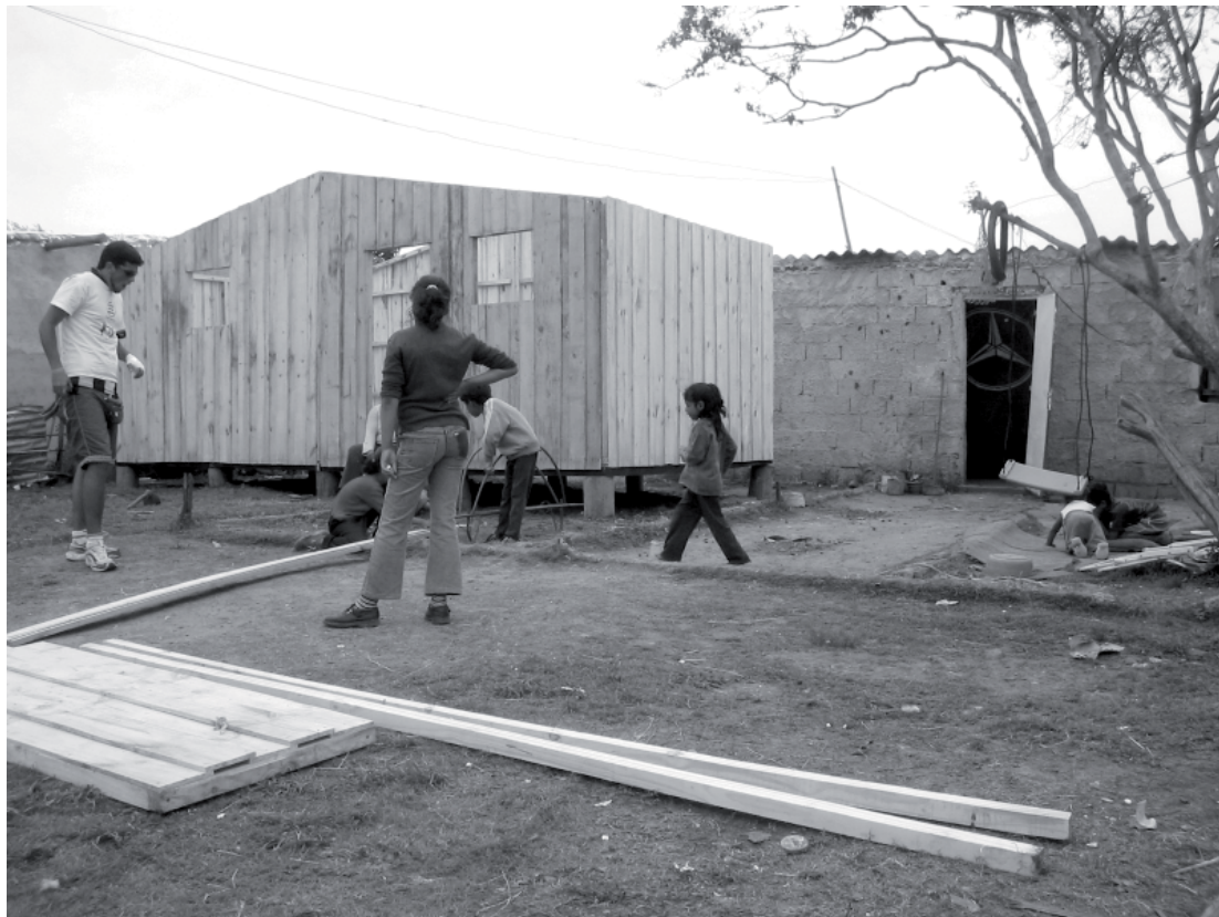
Foto 9. Construcción de mediaguas, Un Techo para mi País, Motevideo 2006.
