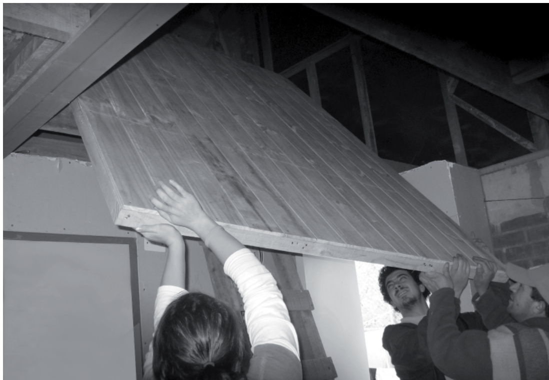
Foto 8. Ampliación de viviendas mediante sistemas prefabricados, Sector Fanja Grecia, comuna Peñalolén, 2006.
