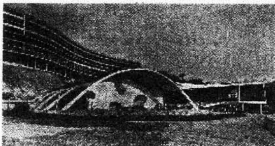
Fig. 3: Conjunto residencial Pedreguhlo. Rio de J. (1960-1962). Fte. Benévolo 1994, Zevi 1980, Segre 1986).
