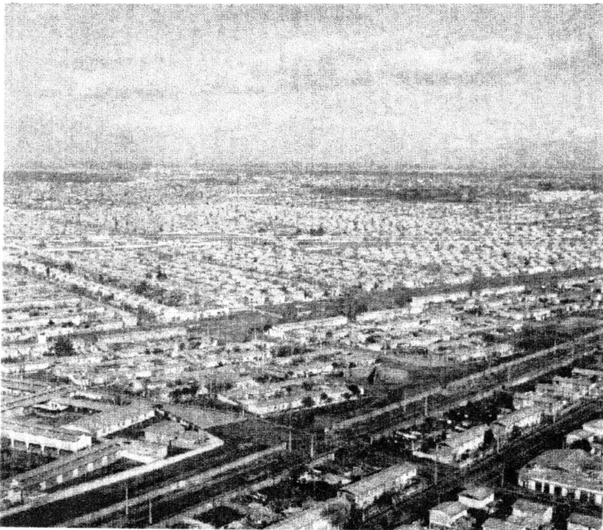
Fig. 4: Chacra La Feria. Población construida para la CORVI en 1955, con 1.100 casas de la fábrica: Construcciones Económicas DESCO, CEDESCO, en la Avda. Ochagavía, con un total de 85.000 m 2 , además de urbanización completa.
