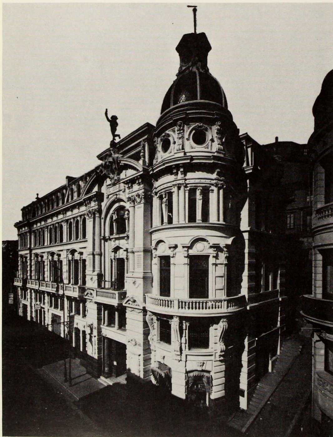
Fotografía de la época del edificio, hoy declarado Monumento Nacional.
