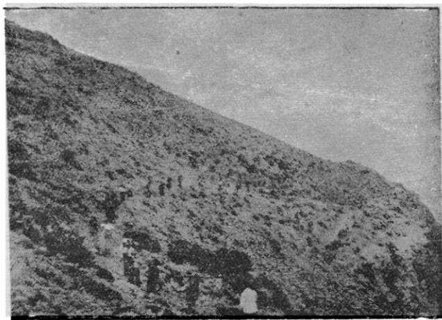
Fig. 3.—Obreros transportando los cables
