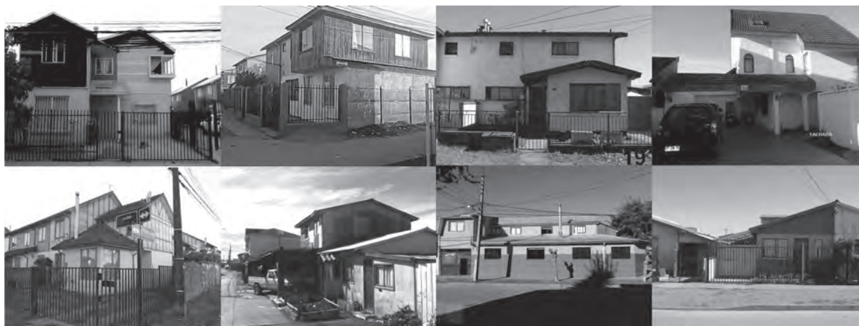
FIGURA 2. VISTA DE ALGUNAS VIVIENDAS
